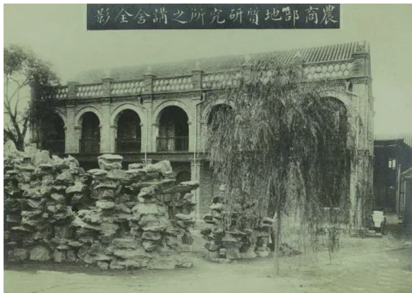
▲ 地质调查所及地质矿产陈列馆旧址（北京丰盛胡同3号地址研究所教室）
