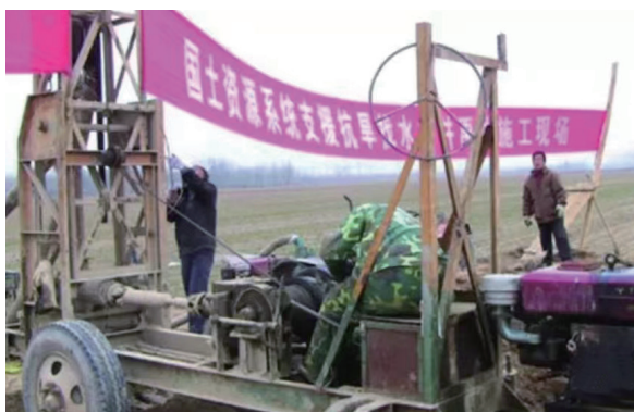
▲ 国土资源系统支援抗旱找水施工现场。
